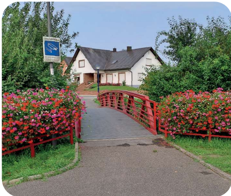
Passerelle des écoliers
